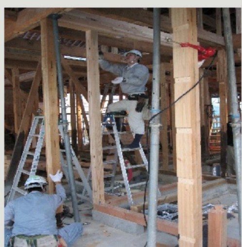
増築部と既存部の接合、間取り変更により柱・梁の入替え及び構造補強中です。
