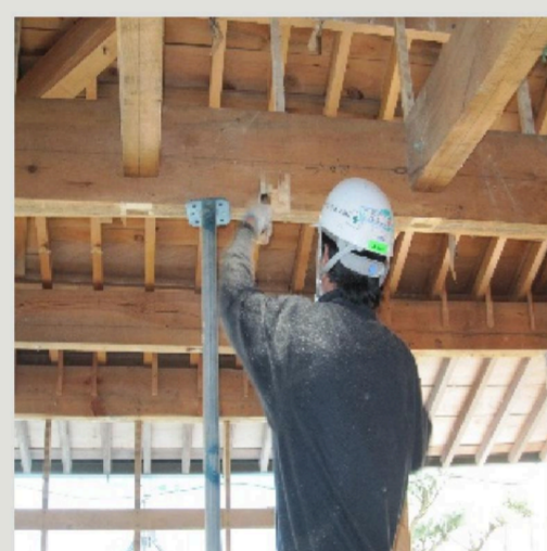
増築部と既存部の接合、間取り変更により柱・梁の入替え及び構造補強中です。
