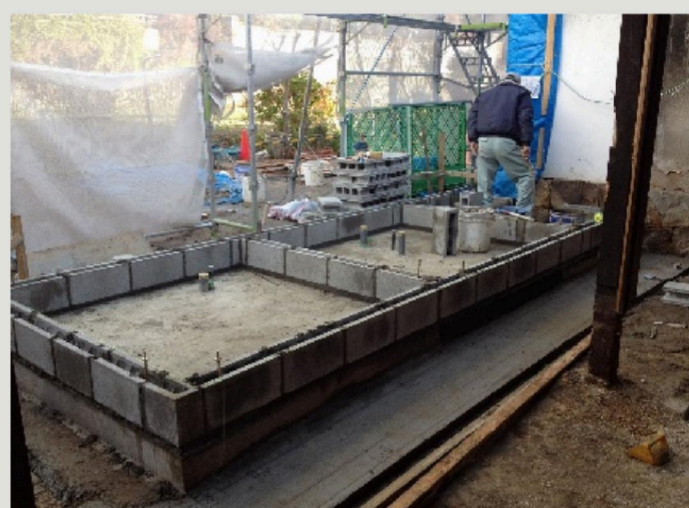
増築部のベタ基礎・既存部はベタ基礎補強で耐震化を図ります
