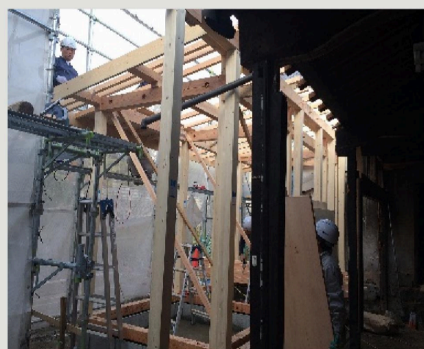
増築部と既存部の接合、間取り変更により柱・梁の入替え及び構造補強中です。
