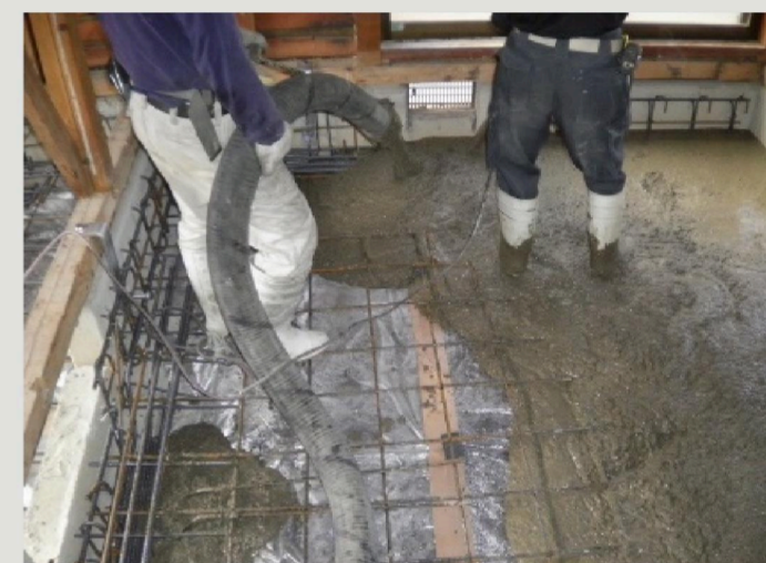
増築部のベタ基礎・既存部はベタ基礎補強で耐震化を図ります
